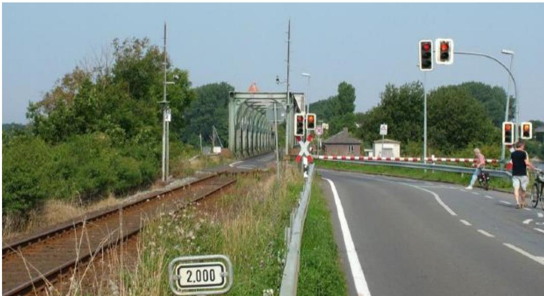
Abbildung 17: Schrankengeregelte Mischnutzung der Eisenbahnbrücke bei Lindaunis
