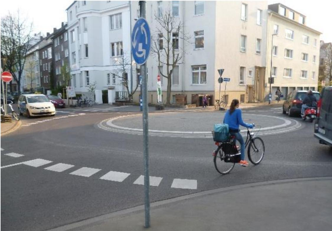
Abbildung 16: Führung des Radverkehrs innerhalb eines Minikreisverkehrs
