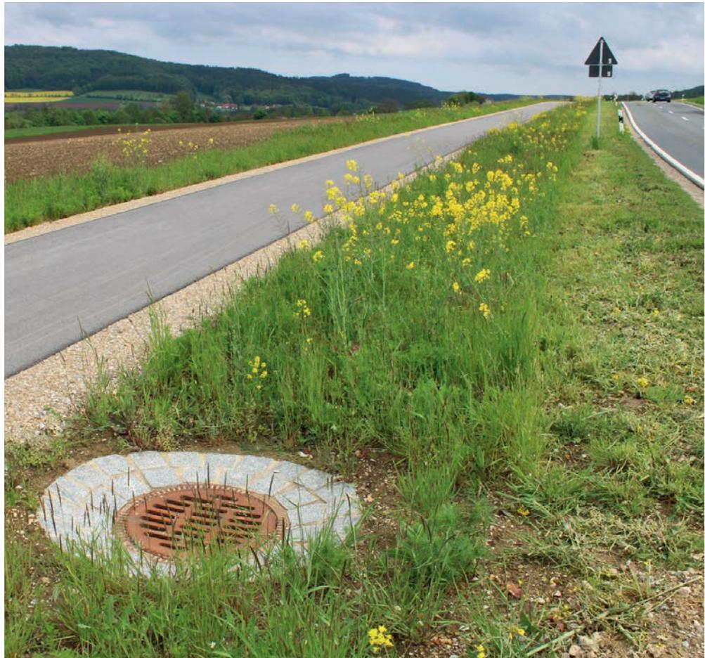
**Abb. 11:** Schachtdeckel einschließlich Einfassung im Bereich einer Mulde
