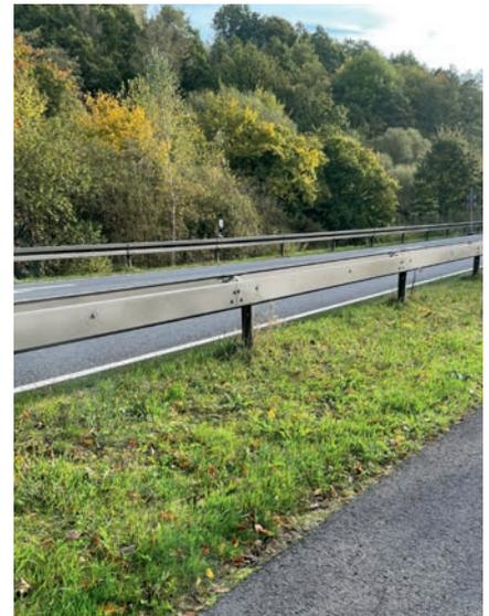
**Abb. 25:** Schutzplanke mit Gleitschutz
