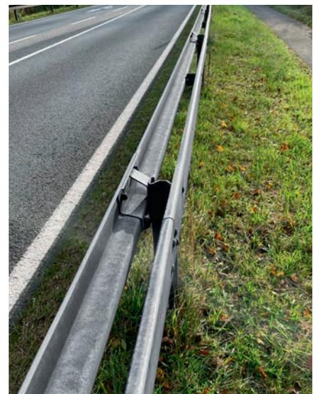
**Abb. 26:** Lage und Ausbildung eines Gleitschutzes
