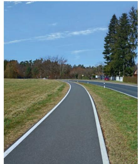
Abb. 18: Fahrbahnrandmarkierung
