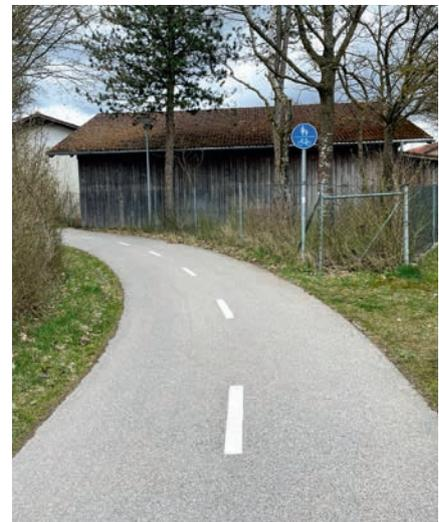
Abb. 19: Mittelmarkierung im Kurvenbereich
